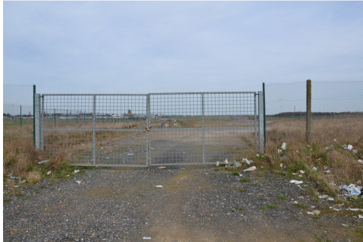
PHOTO - Portail d'accès au site
